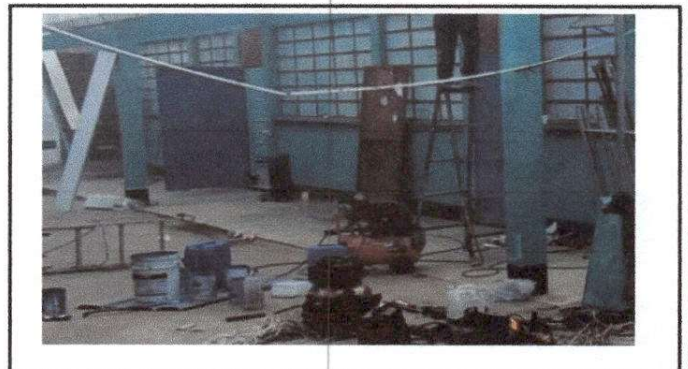
Foto 4: sustitución de puertas
