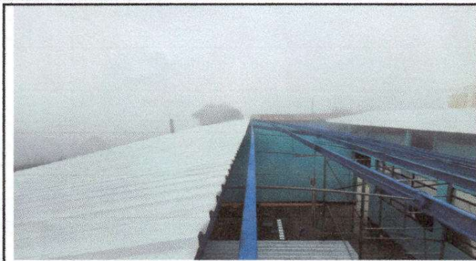
Foto1: sustitución de lamina
