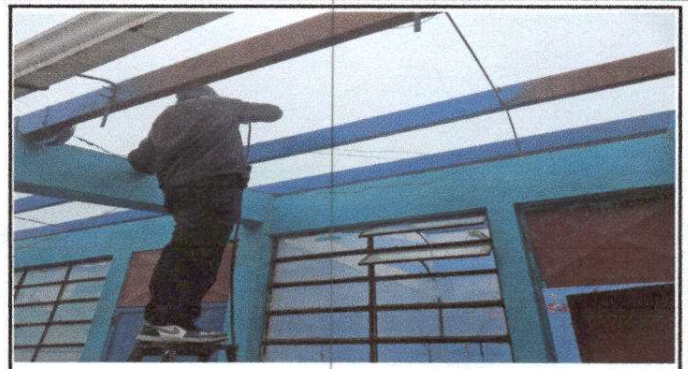
Foto 2: mantenimiento a estructura de metal
