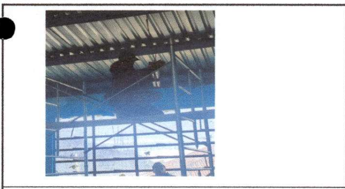
Foto 5: sustitución de lamparas
