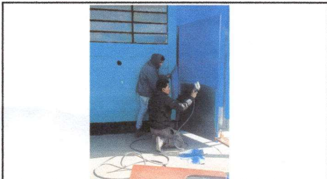
Foto 3: mantenimiento a puertas de metal
